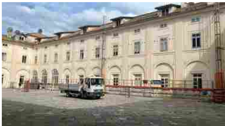
Belvedere di San Leucio a Caserta, partiti i lavori di recupero al sito Unesco
